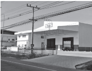
新開タイ(倉庫全景)
